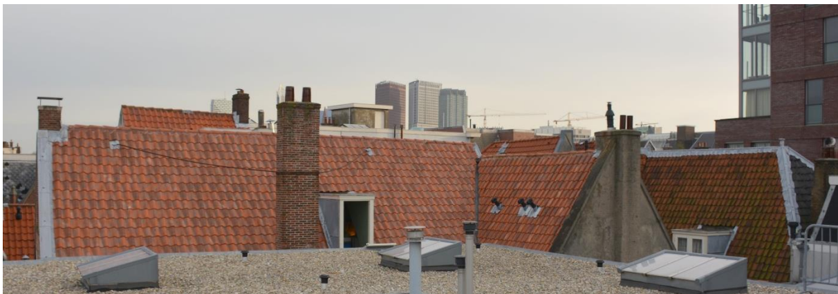
Het dak van het Nobelhuis na restauratie
